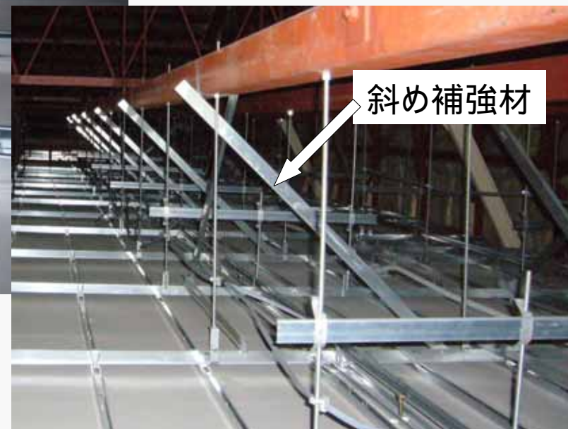
斜め補強材による耐震対策例
